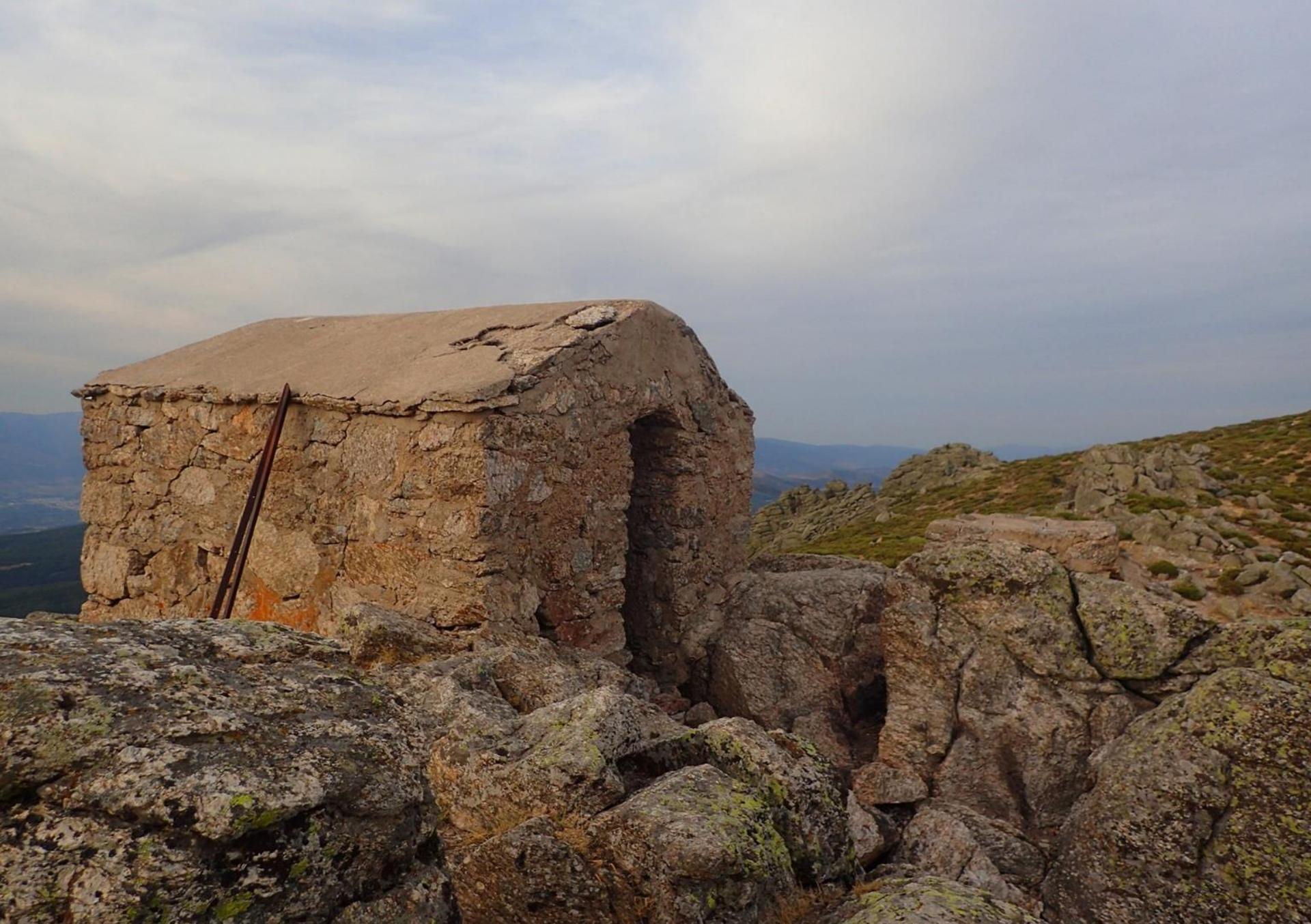
Antigua caseta de incendios utilizada actualmente como refugio de emergencia.
